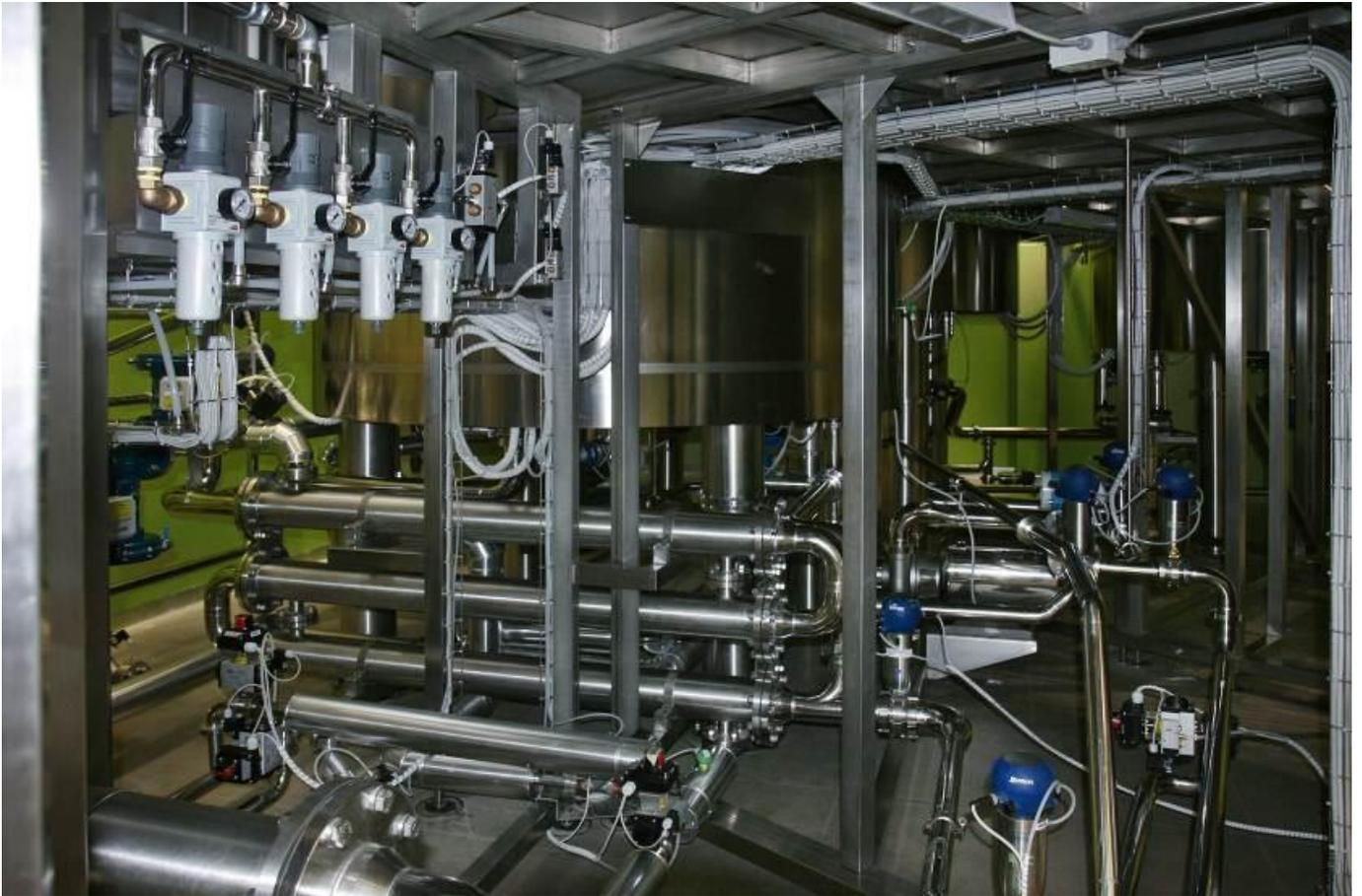
Todas las válvulas están completas con actuador e interruptor de seguridad.
